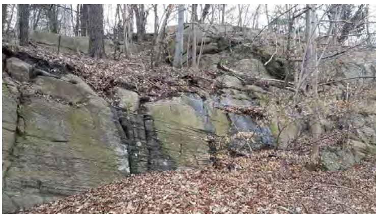
I delar av område för nybyggnation av flerbostadshus sluttar berghällen flackt till medelbrant i östlig riktning. Sprickor är frekventa i hela området.
